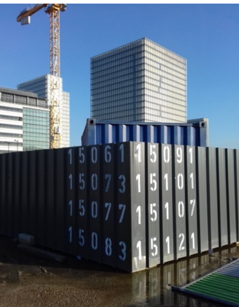
15031-15121 Av. de France, chantier, Paris XIII. Décembre 21
