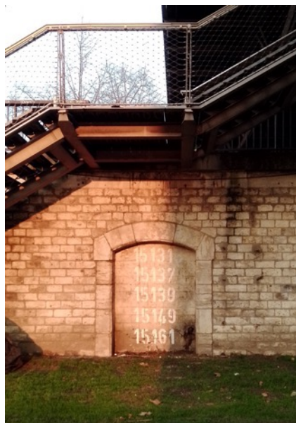
15131-15217 Passerelle Simone de Beauvoir, Paris XIII. Janvier 2022
